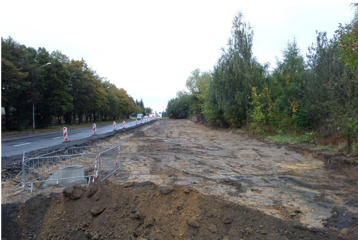
Usunięcie humusu z terenu przyszłego parkingu (stan na dzień 06.10.2021)
