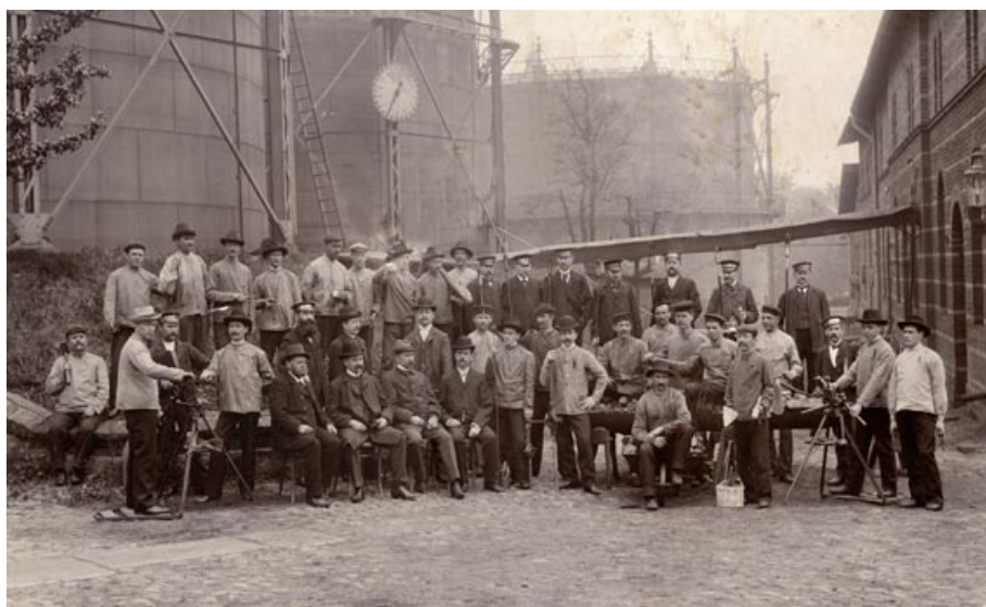
Pracownicy świdnickiej gazowni – zbiory W. Gęborysa
