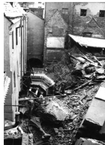
Katastrofa budowlana wieży ratuszowej w 1967 r. (fot. N.N.)
