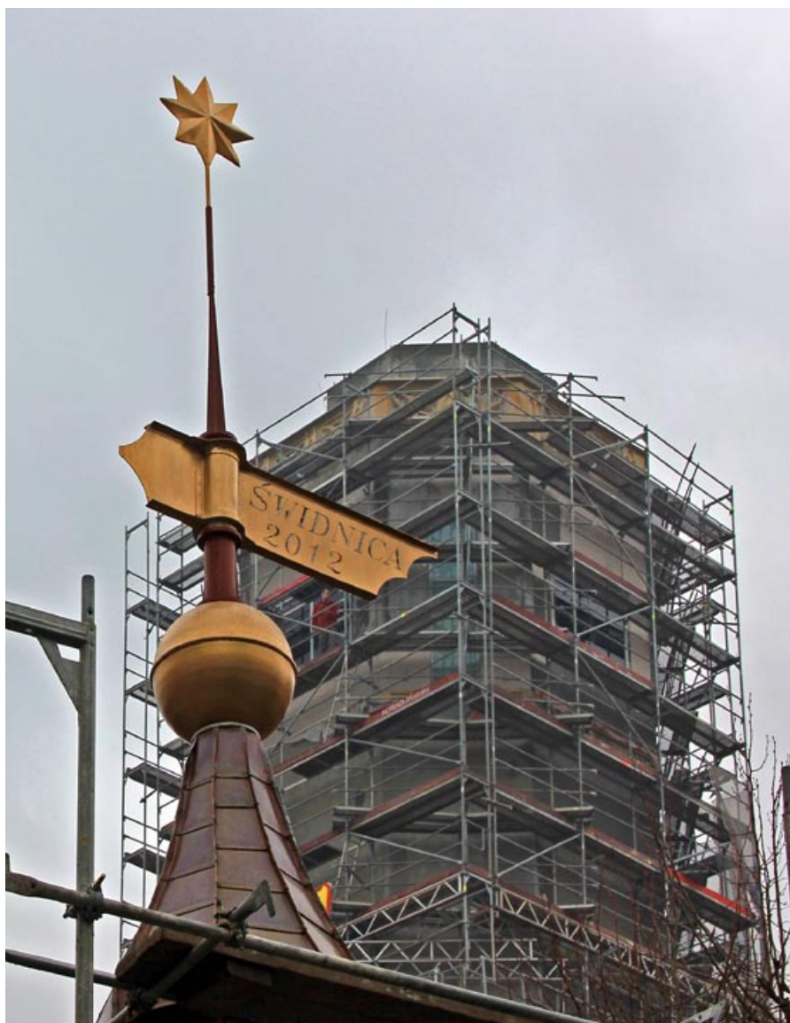
Budowa nowej wieży ratuszowej w 2012 r. (fot. D. Karst)
