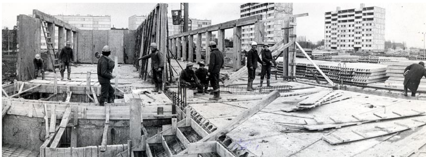
Budowa budynków wielorodzinnych na Osiedlu Młodych II – zbiory Muzeum Dawnego Kupiectwa w Świdnicy
