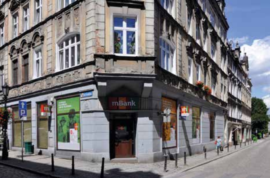
Kamienica w której na parterze znajdował się pierwszy sklep Spółdzielni – „Świt”, obecnie siedziba mBanku (róg ul. Franciszkańskiej i Grodzkiej)
