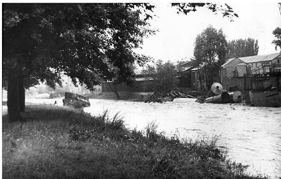
Teren Świdnickiej Fabryki Urządzeń Przemysłowych podczas powodzi w latach sześćdziesiątych XX w. – zbiory Muzeum Dawnego Kupiectwa w Świdnicy
