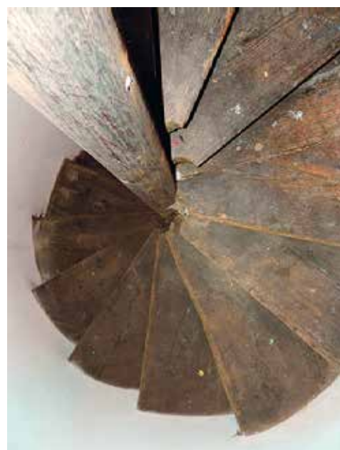
Oryginalne schody kręcone lewoskrętne, rdzeń z drewna dębowego, stopnice i podstopnice z sosnowego (fot. M. Turzańska)
