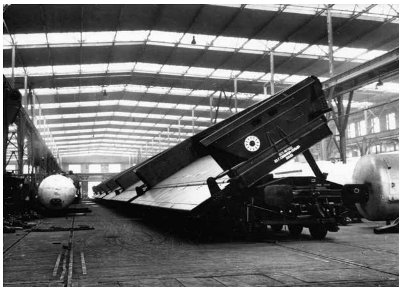
Wagon samowyładowczy 901V do przewozu kamienia i żwiru – w produkcji w latach 1961-1965 – z archiwum T. Kędziory (fot. Hilary Kniat)
