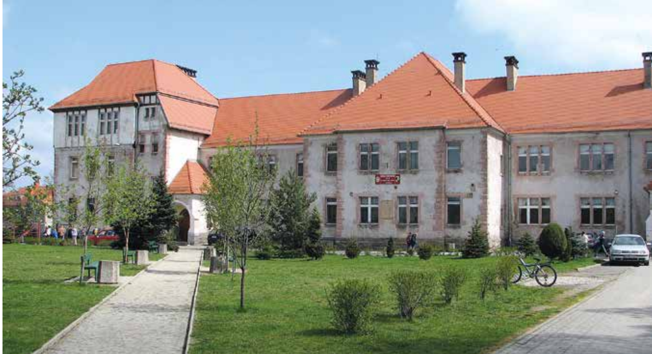
Szkoła Podstawowa nr 8 – dawny obiekt Fundacji Kesslera (fot. W. Rośkowicz)
