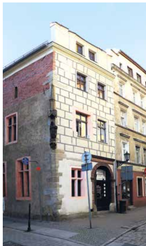
Kamienica przy ul. Łukowej 2 (fot. W. Rośkiewicz)
