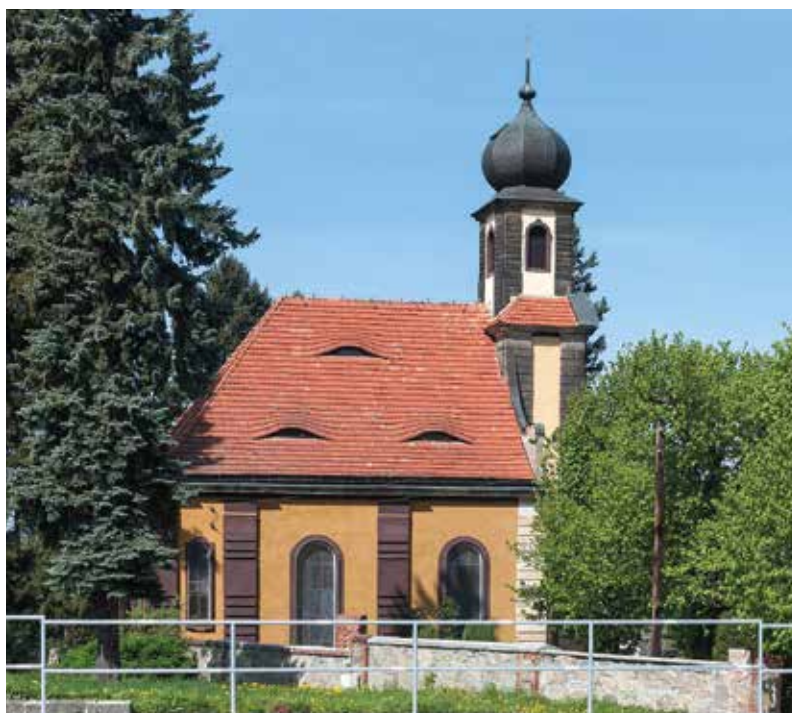
Kaplica na dawnym cmentarzu ewangelickim w Łądku-Zdroju, ufundowana przez Adolfa Kessla (fot. Jacek Halicki)
