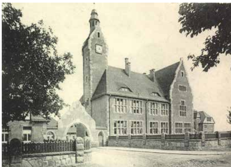
Jeden z budynków Fundacji Kessla w okresie międzywojennym (obecnie kościół pw. św. Andrzeja Boboli) – zbiory Muzeum Dawnego Kupiectwa w Świdnicy
