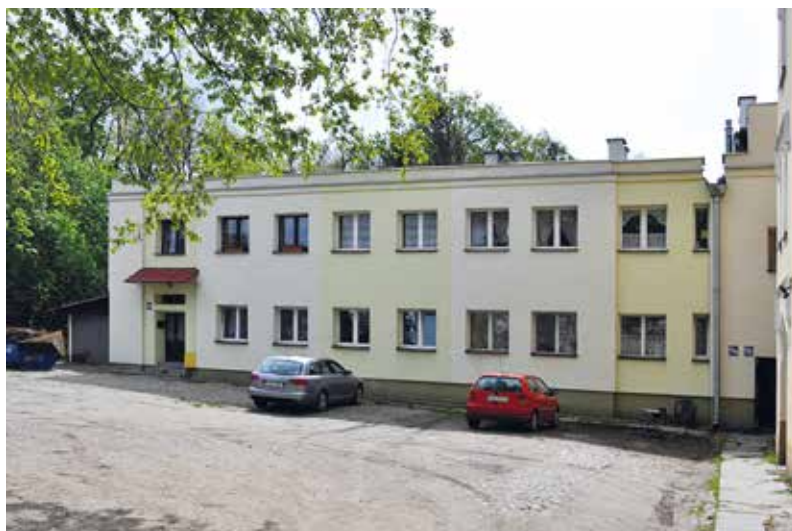
Zachowany fragment fabryki braci Ruffert przy ul. Ofiar Oświęcimskich (fot. A. Dobkiewicz)
