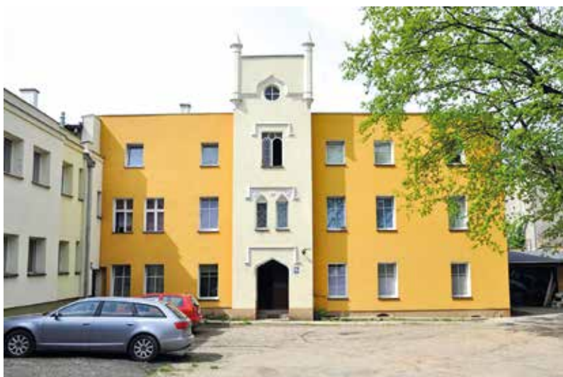
Budynek przy ul. Ofiar Oświęcimskich, gdzie po przyjeździe do Świdnicy mieszkała rodzina Ruffert (fot. A. Dobkiewicz)
