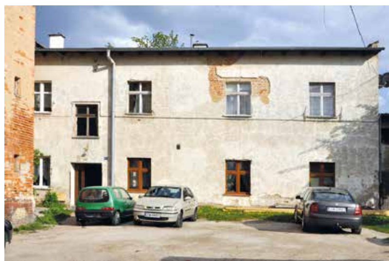
Zabudowania fabryki braci Ruffert przy ul. Generała Władysława Sikorskiego – widok od strony dziedzińca (fot. A. Dobkiewicz)
