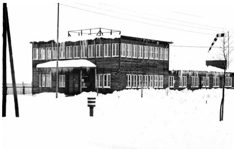
Budynek kontroli ruchu lotniczego, 1940 r.
