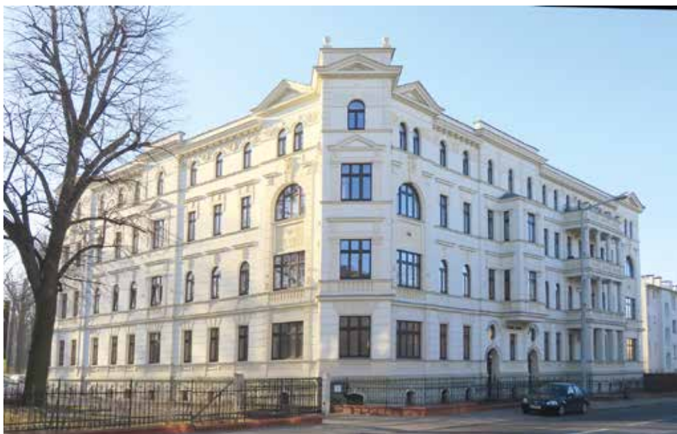
Budynek dawnego Dolnośląskiego Zjednoczenia Przemysłu Cukrowniczego przy ul. Ofiar Oświęcimskich 3/5 (fot. W. Rośkowicz)
