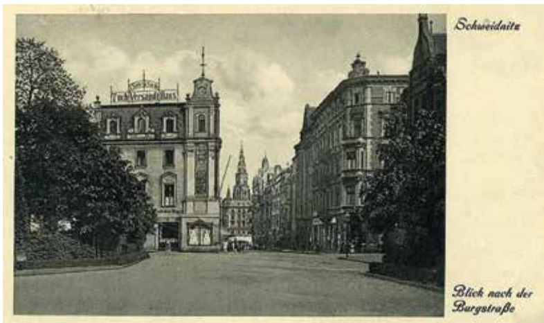
Z lewej nieistniejąca dziś kamienica - siedziba firmy F. Sölter & Starke – źródło ilustracji: www.dolny-slask.org.pl
