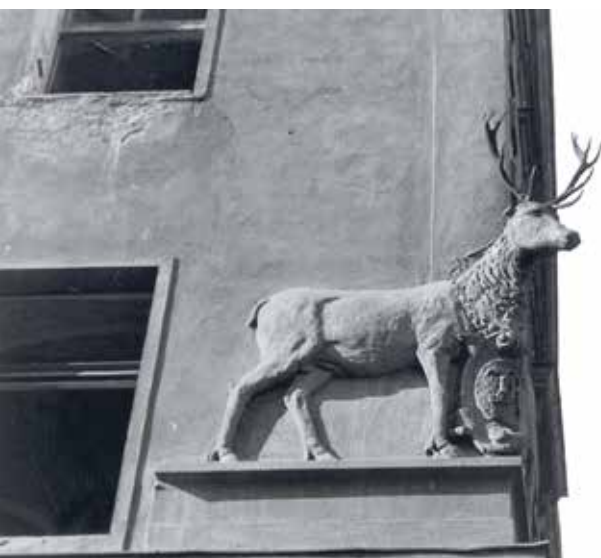
Fragment elewacji kamienicy Pod Brunatnym Jeleniem – źr. ilustracji: www.dolny-slask.org.pl
