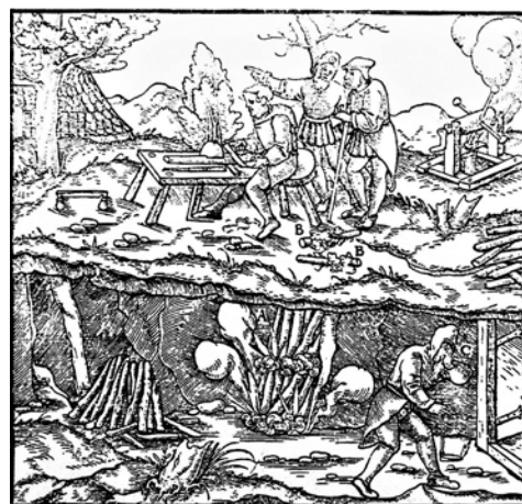
Zapalanie ognia w podziemnych chodnikach celem kruszenia skał
