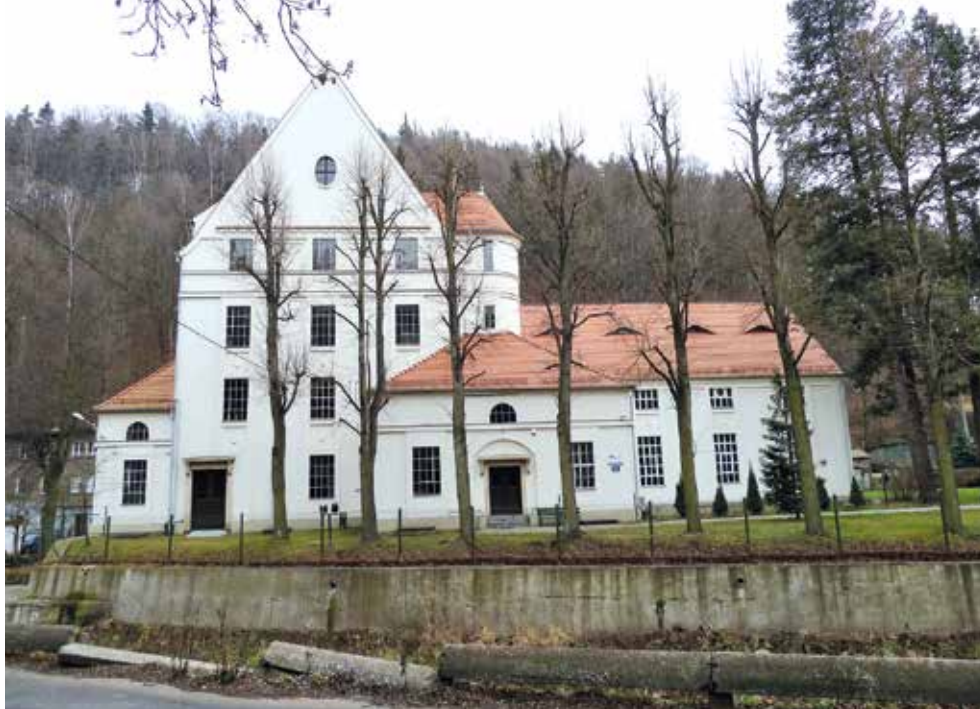
Elektrownia wodna w Lubachowie (fot. W. Rośkowicz)
