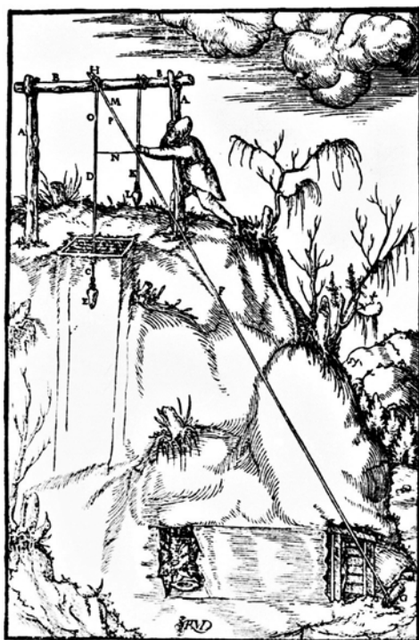
Przeprowadzanie pomiarów przy zakładaniu szybu i sztolni
