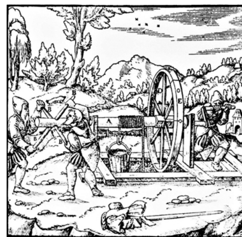
Ręczne wyciąganie urobku górniczego na powierzchnię
