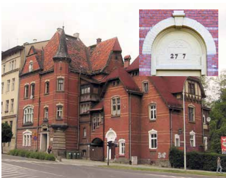
Kamienica przy ul. 1 Maja 27 będąca własnością F. J. Schmidta. W zwieńczeniu portalu wejściowego widoczne symbole masonskie (fot. W. Rośkowicz)
