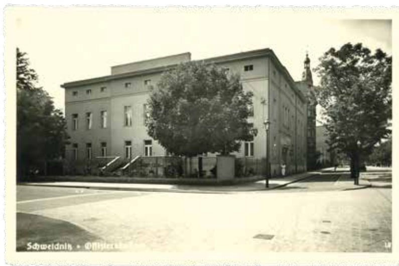
Budynek loży Pod Prawdziwą Jednością przejęty i przekształcony w 1935 r. na kasyno oficerskie – zbiory Muzeum Dawnego Kupiectwa w Świdnicy
