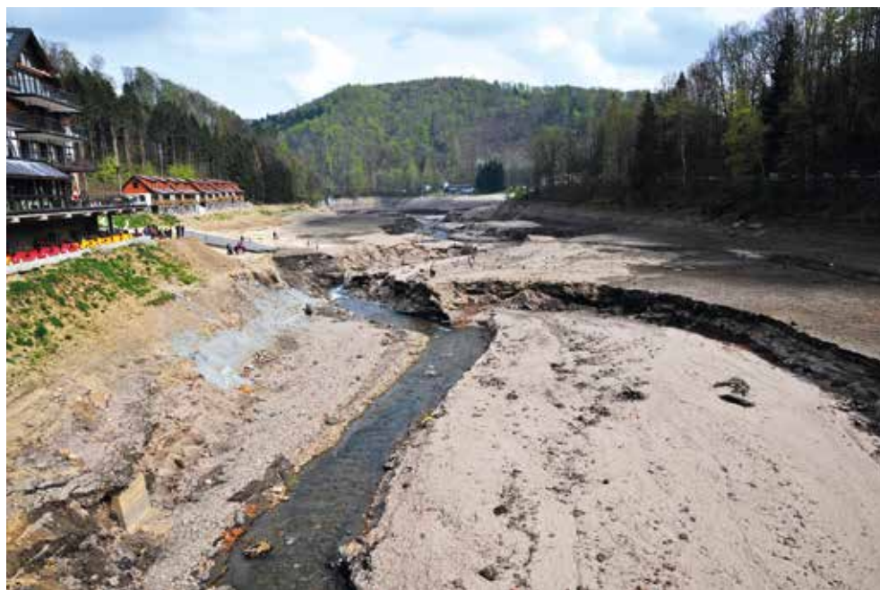
Zasypane osadami dno zbiornika obok hotelu Maria Antonina w Zagórzcu Śląskim, 2016 r. (fot. M. Furmankiewicz)
