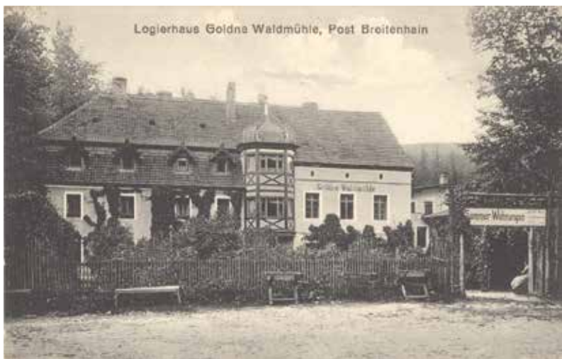
Złoty Las, budynek dawnego gwarectwa - zbiory mojemiasto.swidnica.pl
