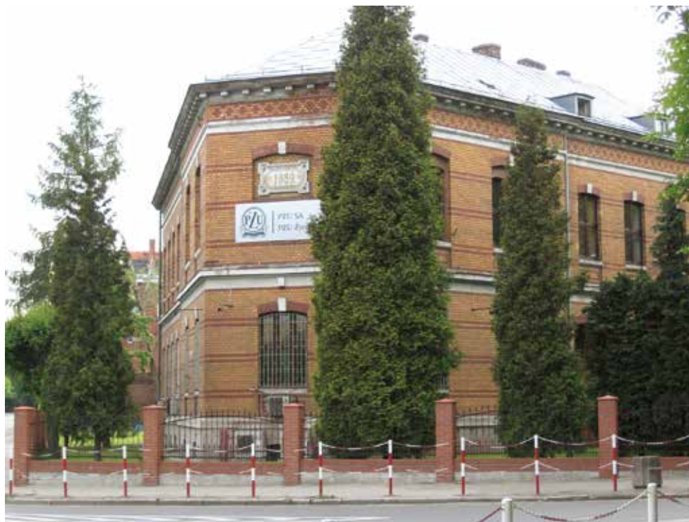
Budynek dawnej preparandy w Świdnicy przy ul. Armii Krajowej 1 (fot. W. Rośkowicz)
