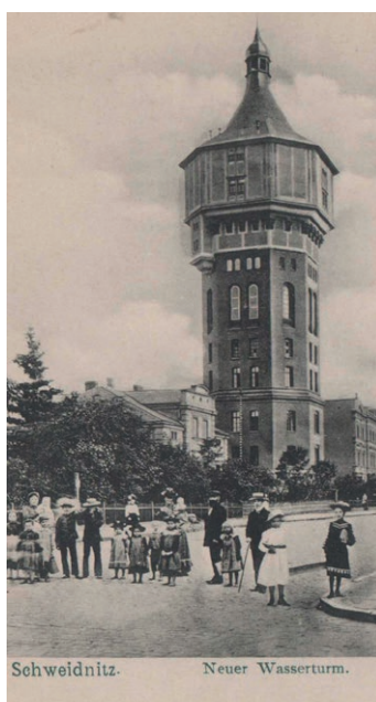
Wieża wodociągowa po rozbudowie z 1902 r. – zbiory autora
